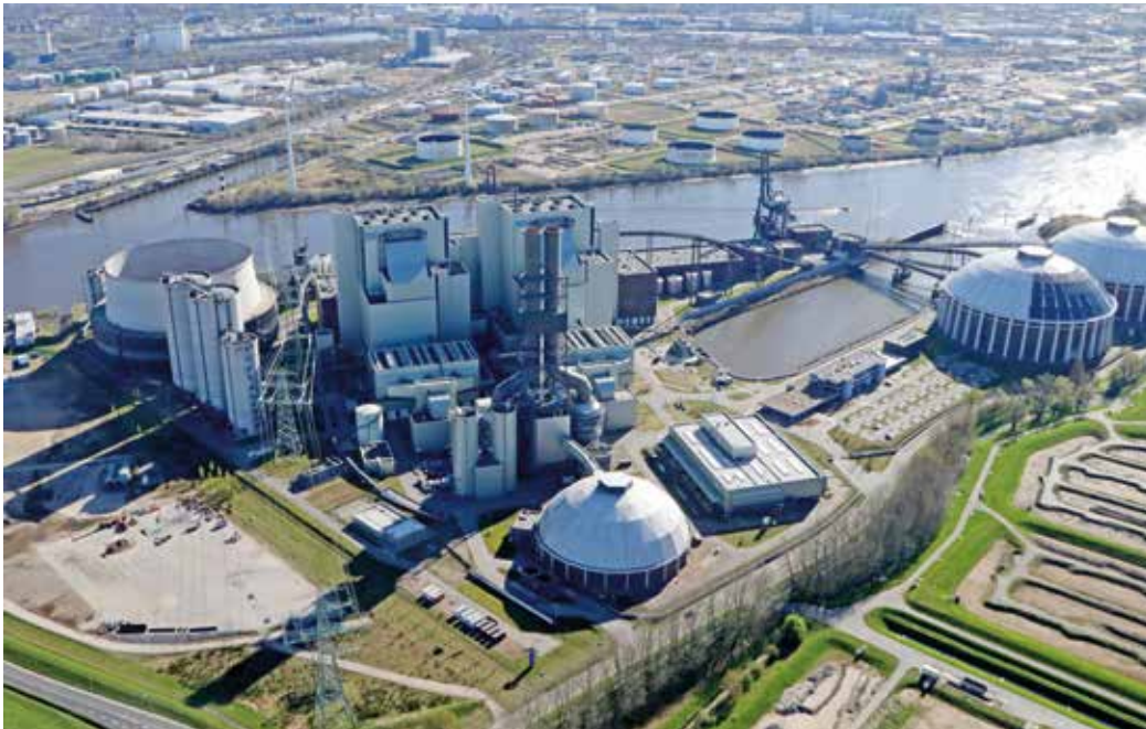
Die Planungen für einen 100-Megawatt-Elektrolyseur am Standort Moorburg im Hamburger Hafen sind bereits weit fortgeschritten
