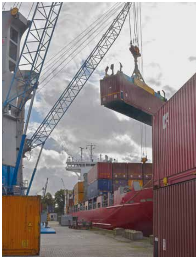
Der Containerterminal von Lehmann verknüpft See- und Bahntransport
