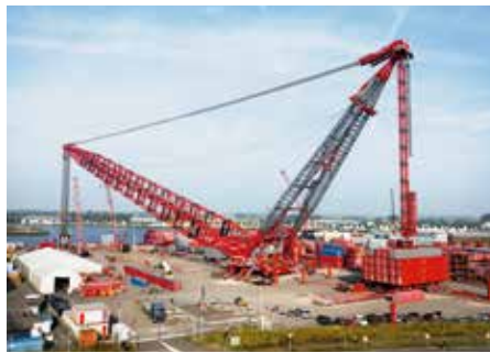
Megakran: Der SK6000 von Mammoet
