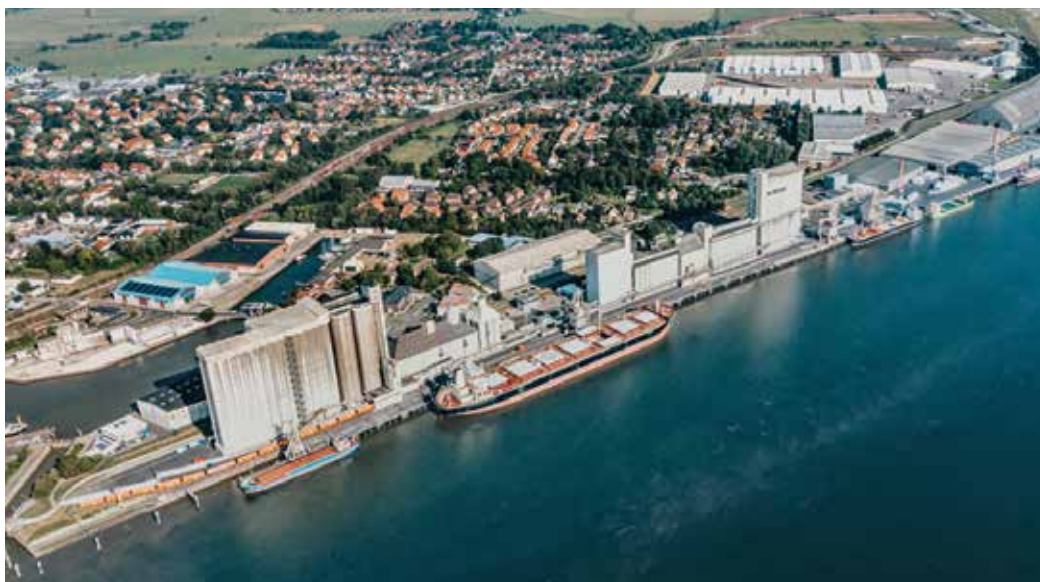
Die weithin sichtbaren Siloanlagen des Hafendienstleisters J. Müller bestimmen die Silhouette von Brake
